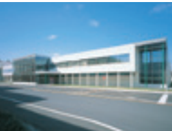
プローチ工場
