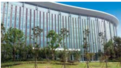
不二越(中国)有限公司(中国) 工具・ベアリング・油圧機器・特殊鋼・工作機械・ロボットの販売 /2004年設立
